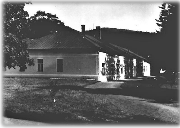
Budova bývalej grófskej koniarne, v ktorej bolo zriadené preventorium pre deti z Oravy, neskôr rehabilitačný pavilón
