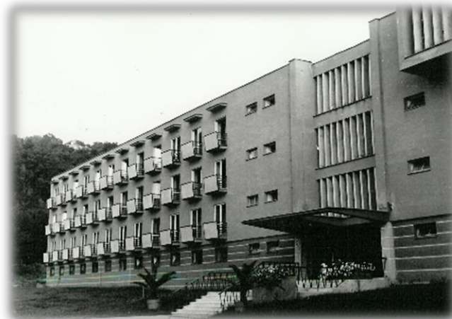
Celkový pohľad na novopostavený pavilón Rehabilitačného výcvikového strediska v roku 1965
