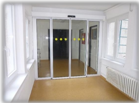
Automatické posuvné dvere na chodbovej spojnici medzi pavilónmi A a C
